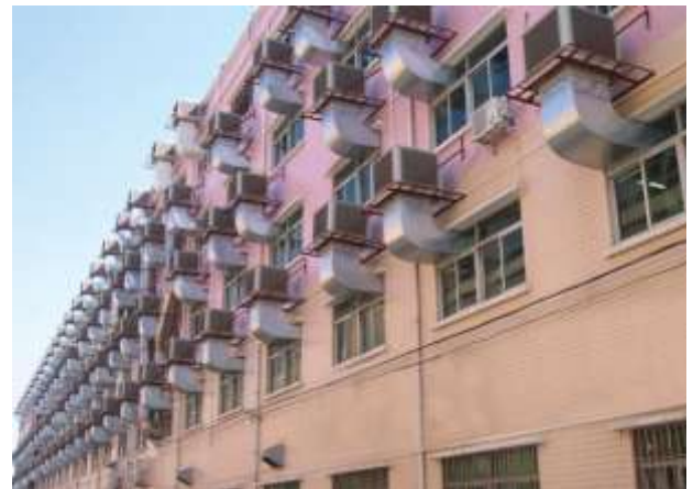
Hình 4.3.95. Kho cơ giới sử dụng hệ thống thông gió tích cực
