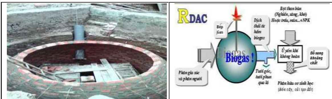
Hình 1.5.16. Hình ảnh về hầm biogas
